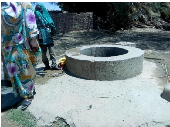
Photo 3 : Puits ouvert à Fada centre
