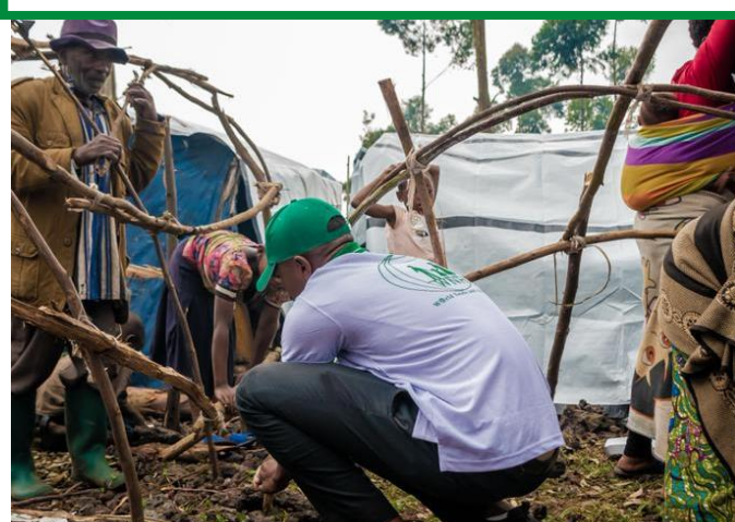
CONSTRUCTION D'ABRIS EN FAVEUR DES PLUS VULNÉRABLES © WNH 2022
