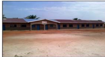
Les salles de classe en durable de l'EP Doya a Doya (Projet SIDA).
