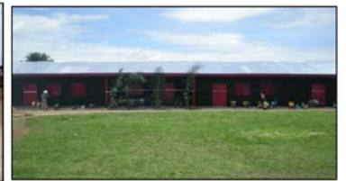
Les salles de classe en semi-durable de l'EP Ombatshi a Tsore (Projet Pooled Fund).
