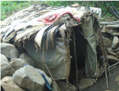
Abri construit par une famille déplacés en bâche avec des sticks de bois – Bishusha – photo prise le 22/01/2020
